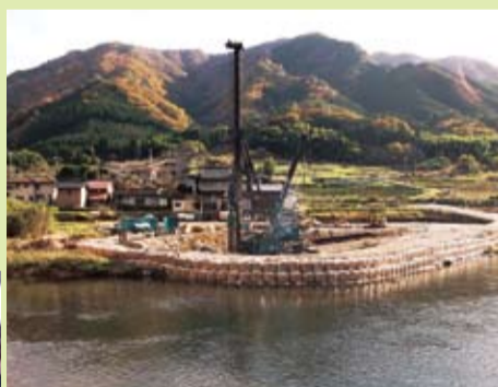
日野川の中に締切をして施工しました。写真は綱矢板施工状況
