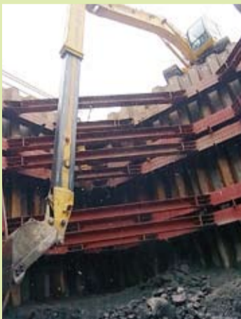
掘削はアームが長〜く伸びるパワーショベルを使います。
