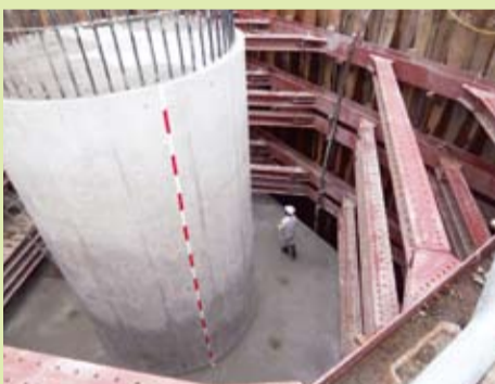
基礎部分、幅9m、柱直径4m、高さ8mの橋脚。下にいる遠藤部長が小さく見えます。
