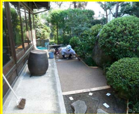
目地材を入れながら入念に仕上げています。
